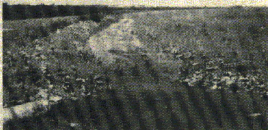
Descarga del agua del arroyo sobre el canal principal.
