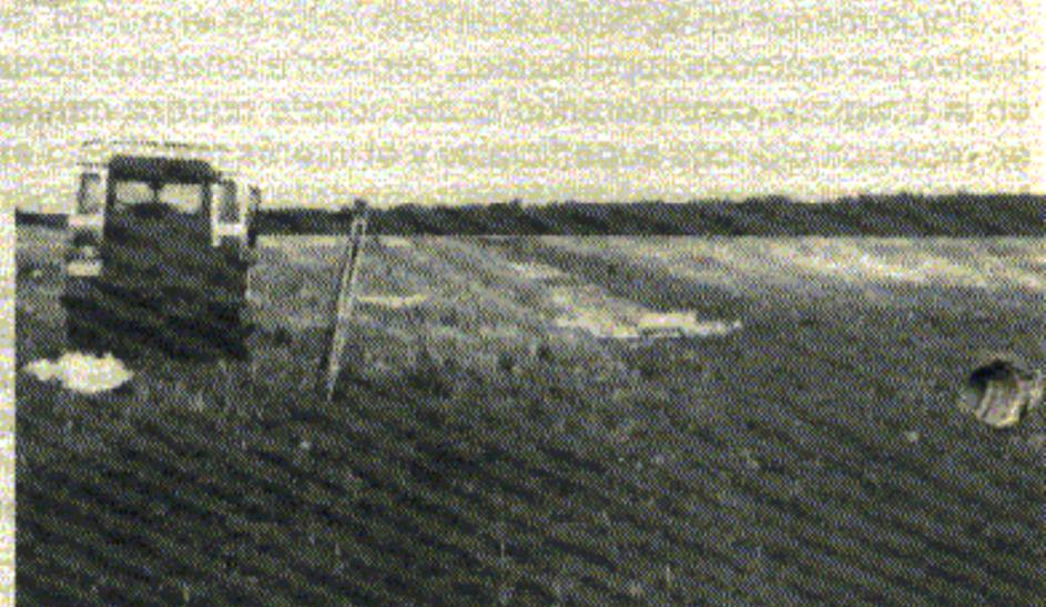
Corte del canal, mediante bolsas con tierra, para conseguir carga hidráulica en el canal de riego.
