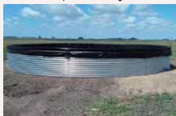
Reparación de tanques australianos de chapa o material con fundas de PVC
